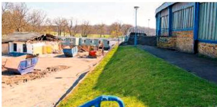
Baustelle Radrennbahn: Alte Baracken und Gebäude werden derzeit abgerissen, um Platz für die neue Sporthalle zu haben. Foto: André Kempner
